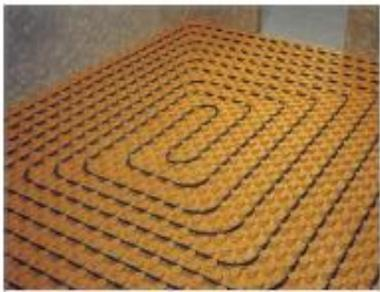
Il riscaldamento degli ambienti è garantito da impianto a pannelli radianti a pavimento in tutti i locali.
