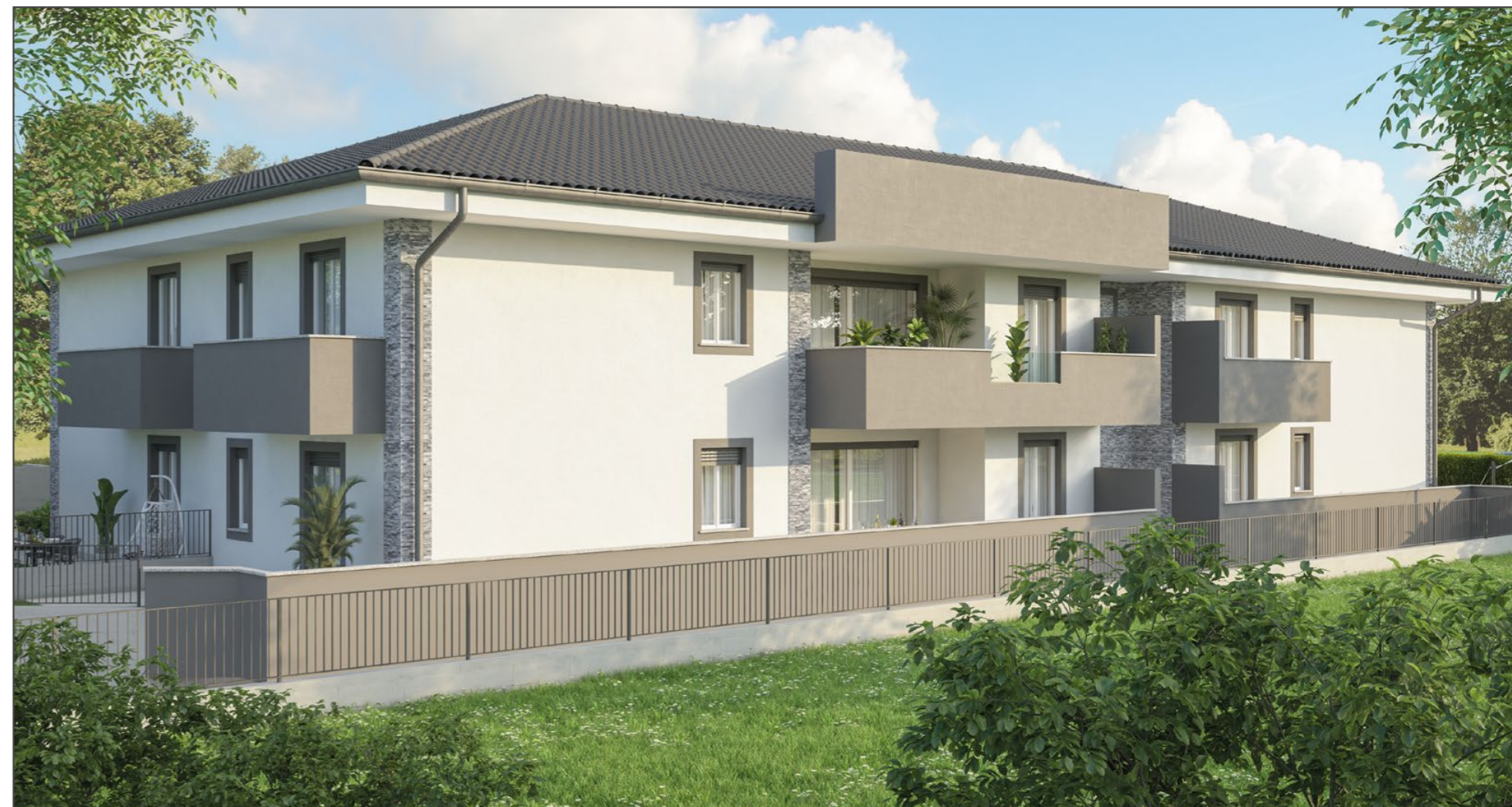
Palazzina di solo sei appartamenti posta in zona tranquilla
